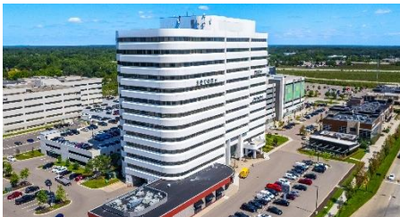
Nueva sede de SEGULA Technologies U.S. en Troy, cerca de Detroit, Michigan (©CBRE)
