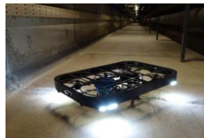
Prototype TOPONE dans les galeries du Palais des congrès FYCMA de Malaga – photo prise lors des tests en conditions réelles.
